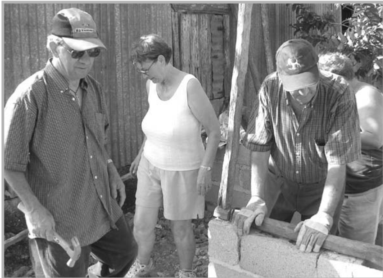
Normand Brisson, Claudette Hovington et Paul-Étienne Deschênes travaillent à la construction de la casa de Géronimo. Une maison qui est un cadeau du ciel pour les gens qui vivent dans un état d'extrême pauvreté.
